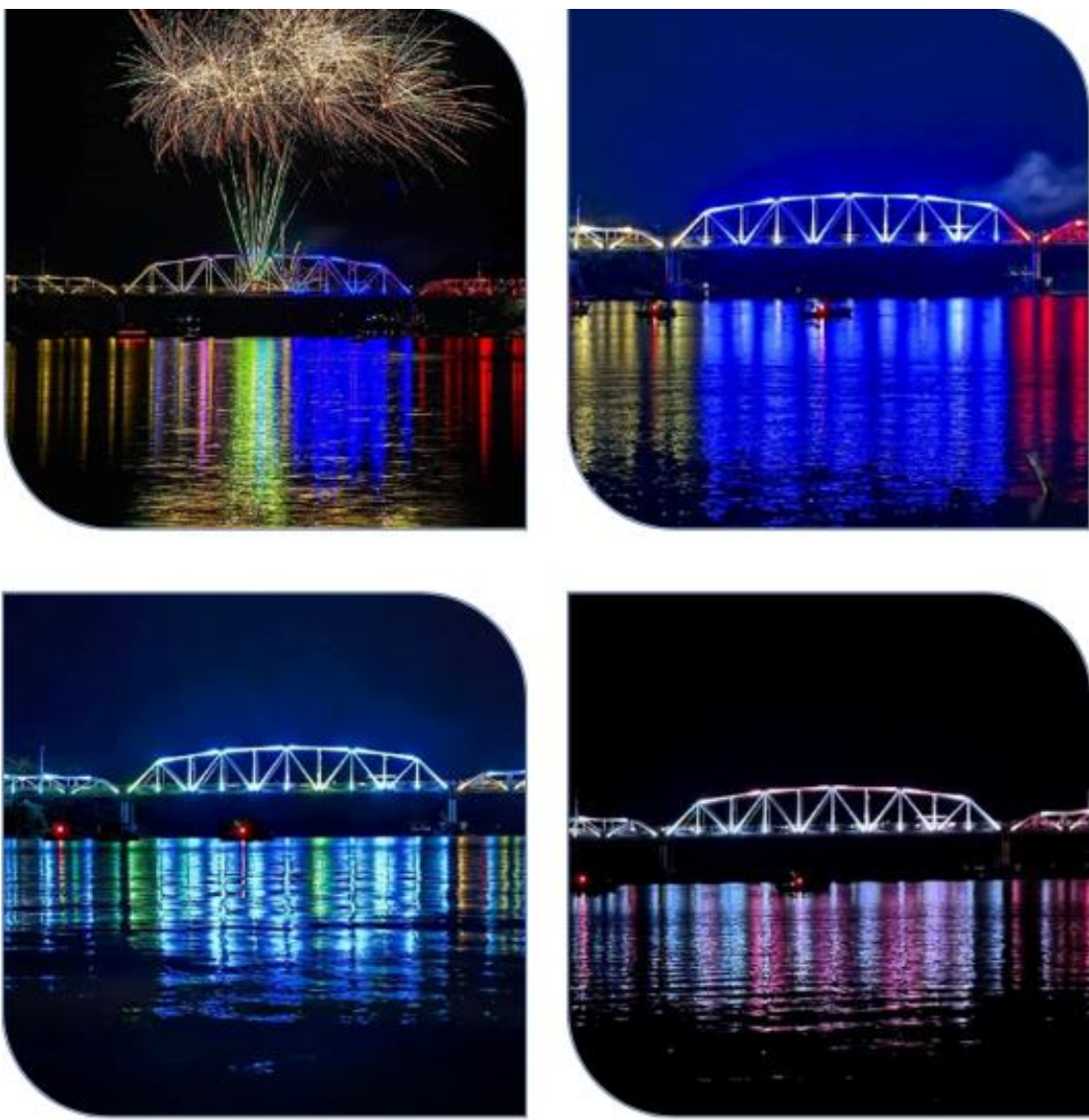
Fotos.5: Fotos de iluminación ornamental del Puente Internacional José Antonio Páez.
